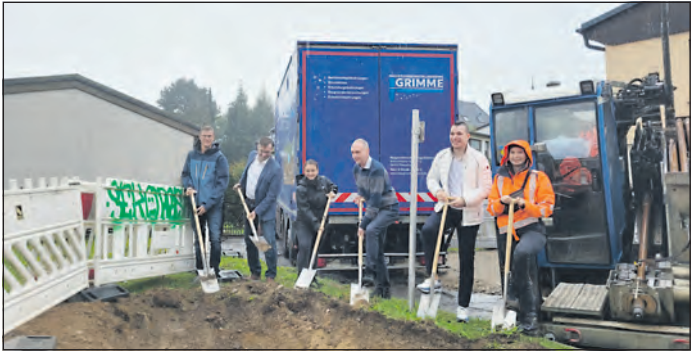
Beim symbolischen Spatenstich – v.l.n.r.: Jens Gelbrich (Verbandsingenieur ZAL), Lars Merten (Werkleiter ZAL), Lisa Krauß (Bauamtsleiterin von Gößnitz), Sven Köhler (Ingenieurbüro Katzung GmbH), Patrick Albrecht (Bürgermeister von Gößnitz) und Frau Hüttner (Bickhardt Bau Thüringen GmbH). Foto: Gina Hartmann
