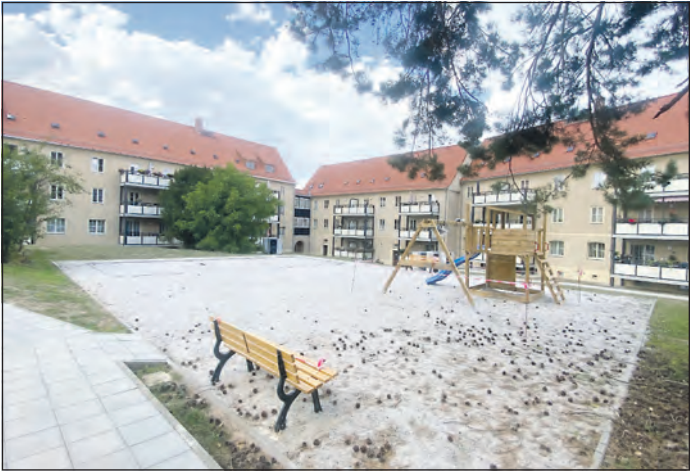
Die denkmalgerechte Instandsetzung der Wohnanlage Südstraße/Käthe-Kollwitz-Straße stellte hohe Anforderungen an Planung und Ausführung. Das Ingenieur- und Planungsbüro Holger Döbelt GmbH & Co. KG überzeugte dabei mit einem sensiblen Umgang mit der historischen Bausubstanz.
