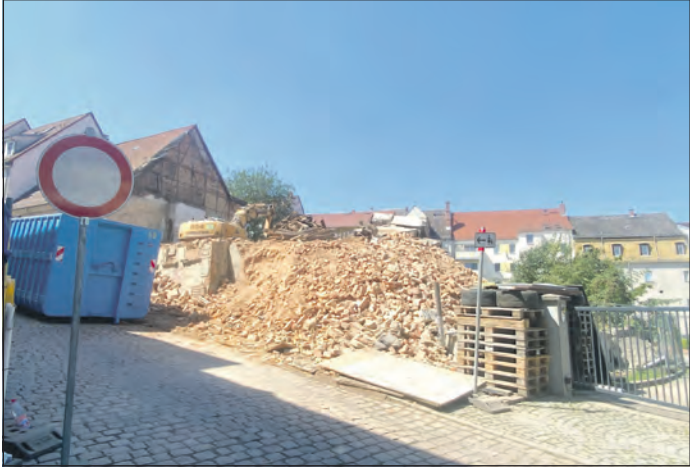
Abrissarbeiten an den Gebäuden Kesselgasse 5 bis 7 im Auftrag der SWG.
