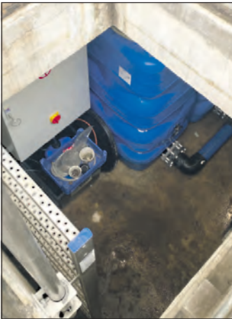
Unterirdische Schaltzentrale für neuen Trinkwasserspender und Springbrunnen auf dem Altenburger Marktplatz.
