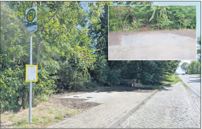
An der Bushaltestelle in Burkersdorf entsteht ein neues Wartehäuschen. Der alte Unterstand wurde abgerissen. Fotos (2): Gina Hartmann
