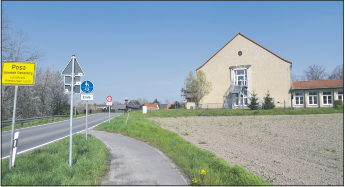
Mit Bewilligung von Fördermitteln startet im zweiten Halbjahr der Radwegebau am Ortseingang des Starkenberger Ortsteils Posa, entlang der L1361.
