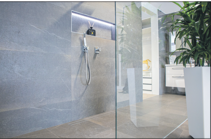
Eine bodenebene Dusche ist das Herzstück eines barrierefreien Badezimmers – und auch optisch ein Gewinn. Hier wurden großformatige Fliesen in edlem Holzdesign im gesamten Raum verlegt und mit einer dünn-schichtigen Fußbodenheizung kombiniert. Wichtige Voraussetzung war die sichere Verbundabdichtung des bodengleichen Duschbereichs. Foto: Saint-Gobain Weber/txn
