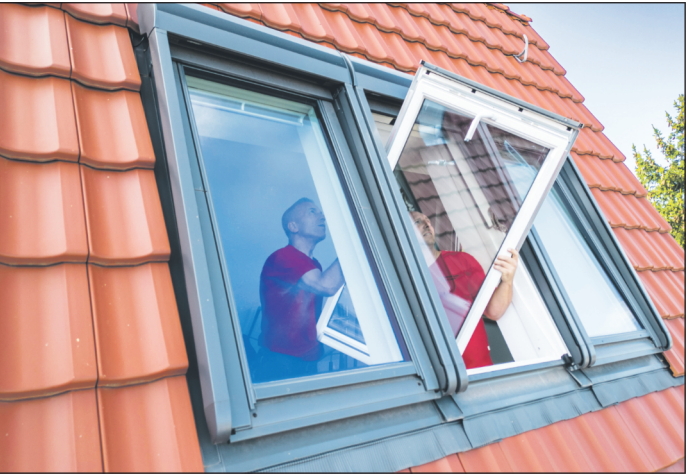
Wird ein Dachfenster eins zu eins ausgetauscht, geht dies binnen weniger Stunden über die Bühne, weil kein großer Eingriff in die Dachstruktur nötig ist. Foto: djd/TLS-Dachfenster
