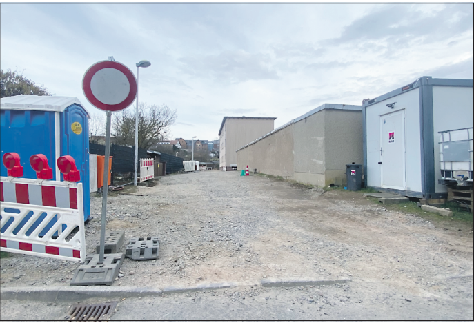
Grabenstraße in Altenburg – Bauarbeiten sollen bis voraussichtlich Anfang April abgeschlossen sein. Foto: sk
