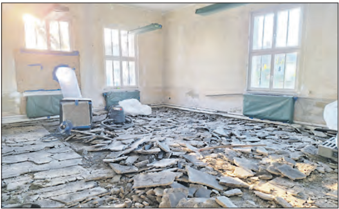
Für die anstehende Fußbodensanierung ist die Entkernung der Amtsstuben erforderlich (hier ehemals Kleiner Saal im Erdgeschoss).
