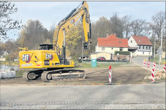
Ende des Jahres 2025 konnte der Abriss des Gebäudes von der Gemeinde realisiert werden.
