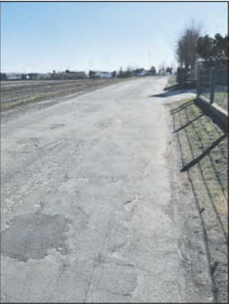
Bauanfang des 1. Bauabschnittes in Kleintreben (Ist-Zustand).
