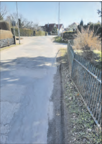
1. Bauabschnitt in der Ortslage Fockendorf (Ist-Zustand).
