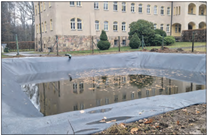
Derzeit wird der Feuerlöschteich in Plottendorf saniert.
