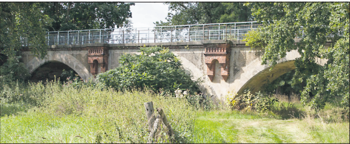
Das zweite der fünf unter Denkmalschutz stehenden Betonbogenviadukte entlang der ehemaligen Eisenbahnstrecke Altenburg-Narsdorf konnte zur Wander-/Radwegbrücke umgebaut werden – das Pleißeflutviadukt in Kotteritz.
