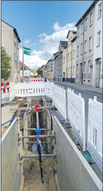
Die Mitarbeiter vom Eigenbetrieb Stadtwerke Schnaudertal (ESS) bereiteten am 15. September das provisorische Verblinding für den Neuanschluss der Wasserleitung vor. Fotos (3): sk
