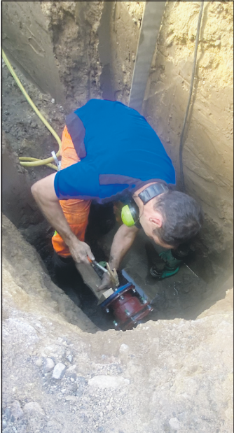
Die Mitarbeiter vom Eigenbetrieb Stadtwerke Schnaudertal (ESS) bereiteten am 15. September das provisorische Verblinding für den Neuanschluss der Wasserleitung vor. Fotos (3): sk
