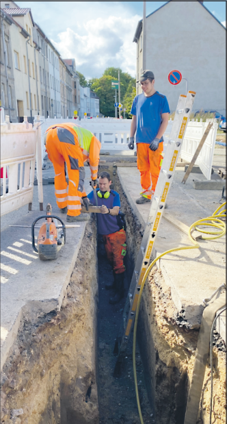
Die Mitarbeiter vom Eigenbetrieb Stadtwerke Schnaudertal (ESS) bereiteten am 15. September das provisorische Verblinding für den Neuanschluss der Wasserleitung vor. Fotos (3): sk
